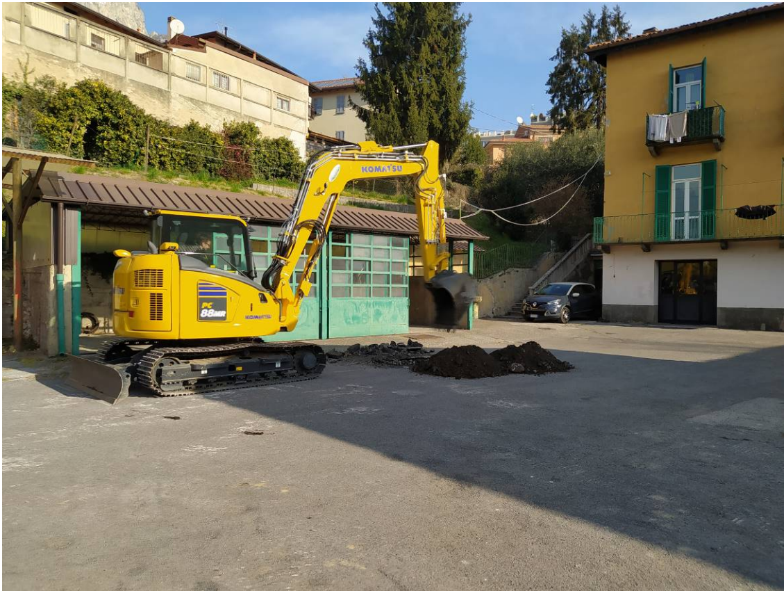
Foto 1: fase di esecuzione scavi
