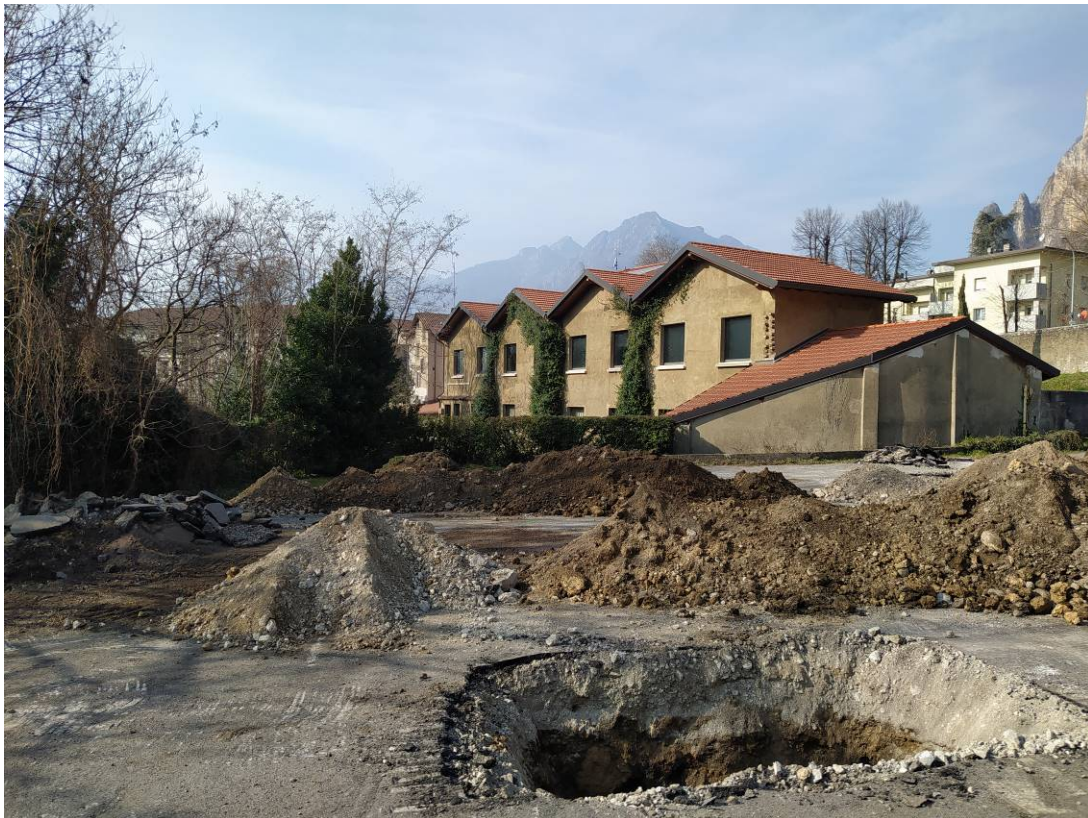
Foto 2: fase di esecuzione scavi
