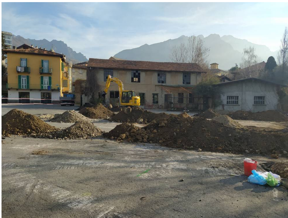
Foto 3: fase di esecuzione scavi
