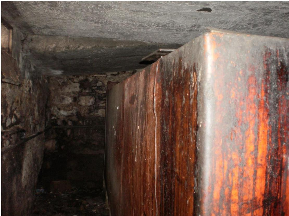
**Figura 9: serbatoio deposito di gasolio da bonificare e smaltire da altra ditta**
