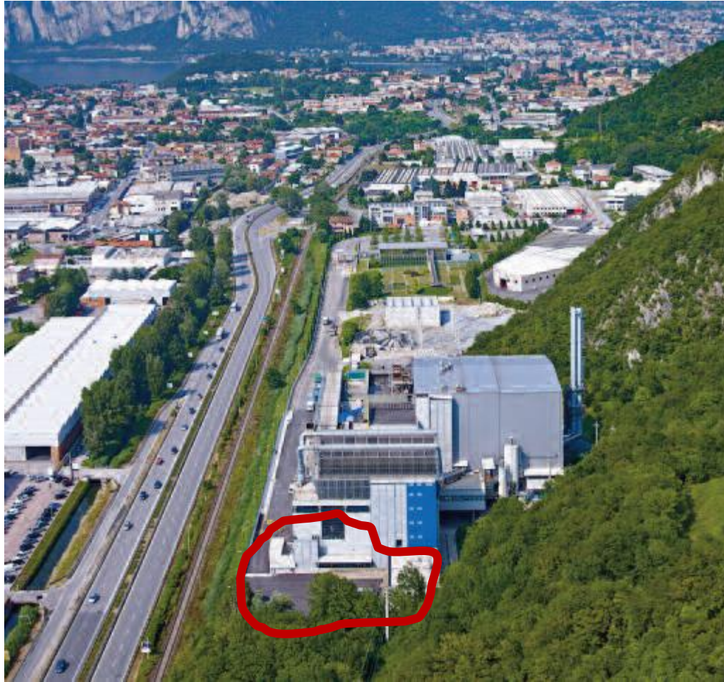
Vista in direzione Milano - Lecco
