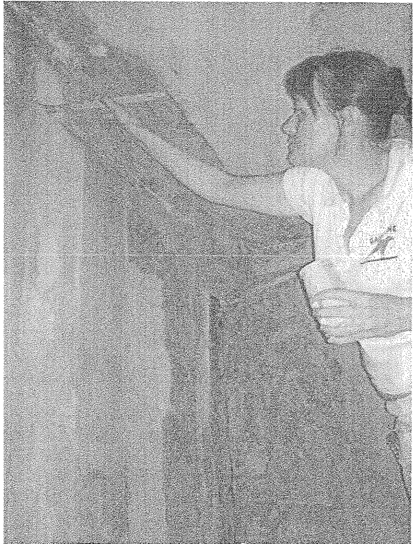
Velatura con pigmento in emulsione acquosa in stanza 5.
