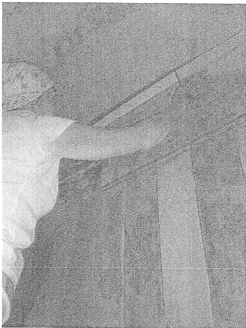
Intervento di integrazione cromatica, ripresa dei profili a pennello, in stanza 5.
