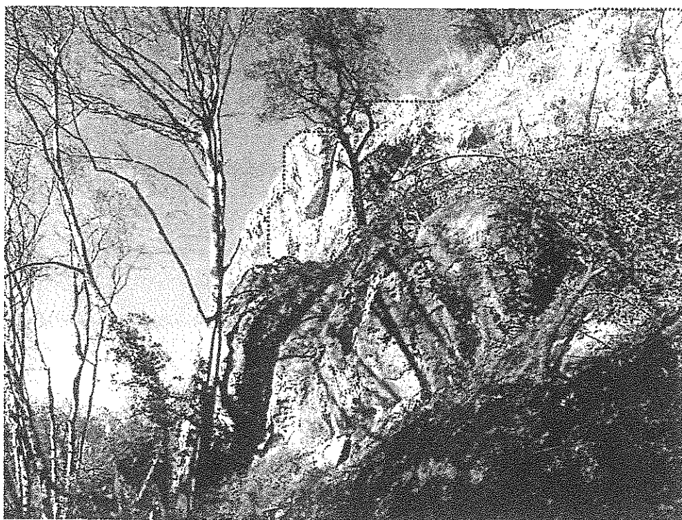
F2: visibile il limite degli attuali interventi di messa in sicurezza
